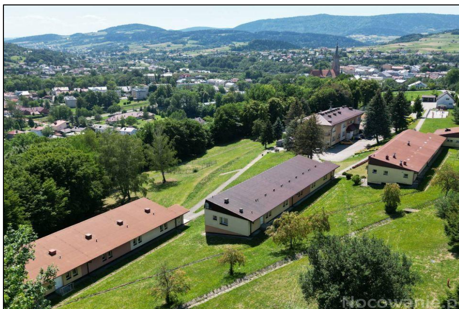
Widok Ośrodka PW
