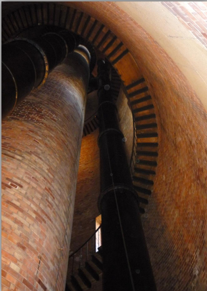
Wieża ciśnień wewnątrz - komin i schody skруcone
