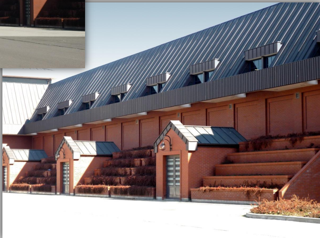
Budynek stacji ozonowania wody
