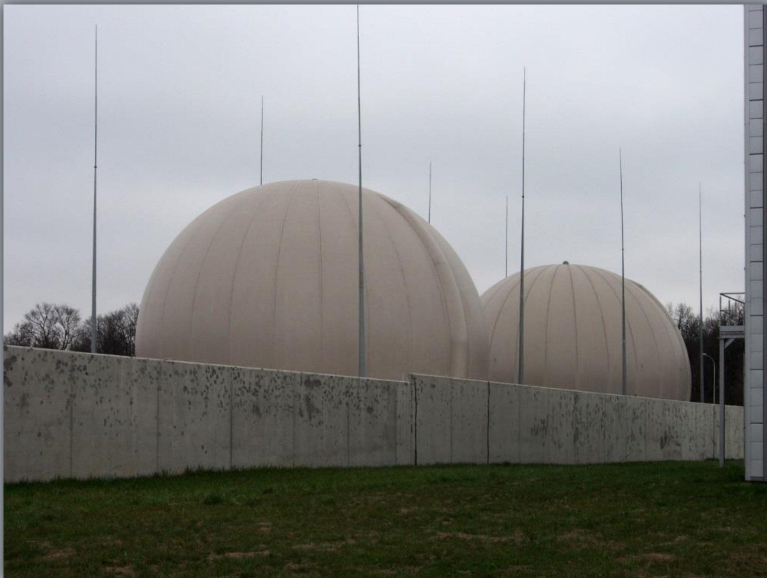
Zbiorniki z biogazem powstającym w procesie technologicznym
