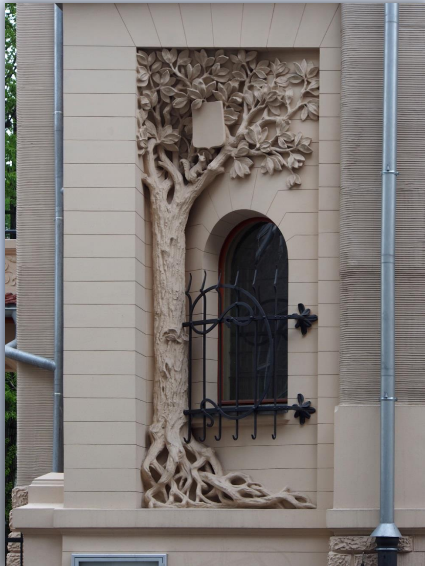
Secesyjne obramowanie okna od strony ulicy
