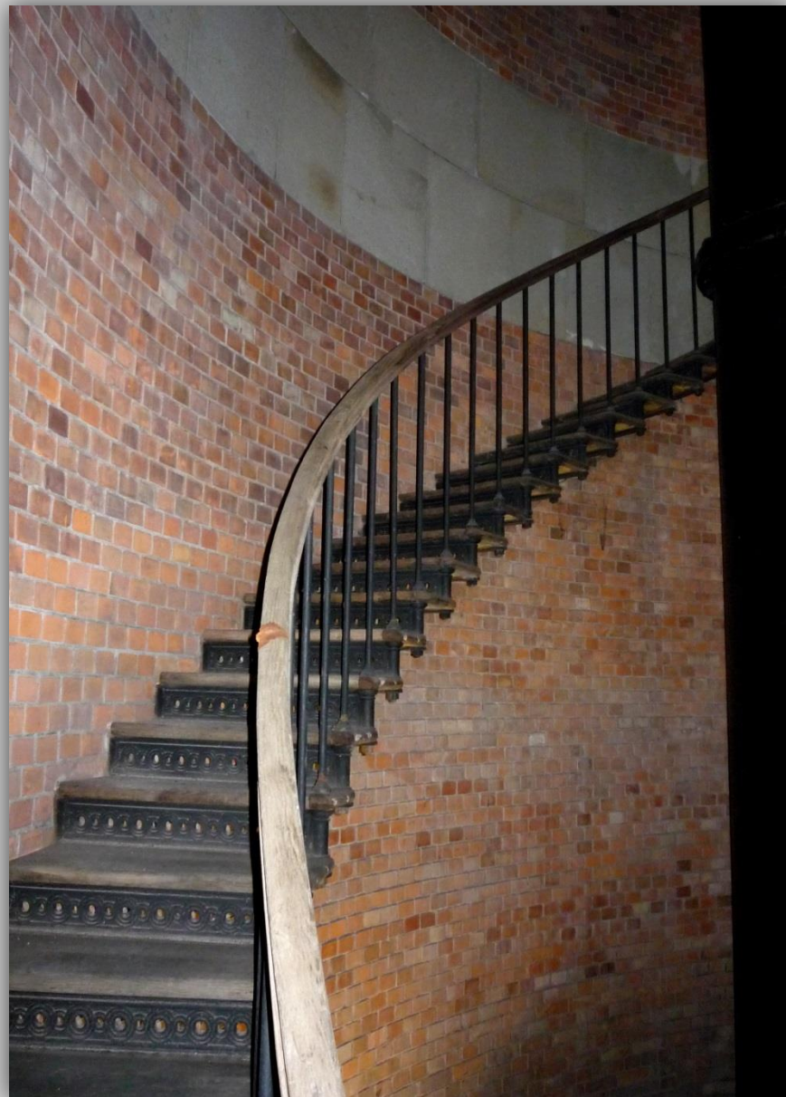
Wieża ciśnień wewnątrz - komin i schody skруcone
