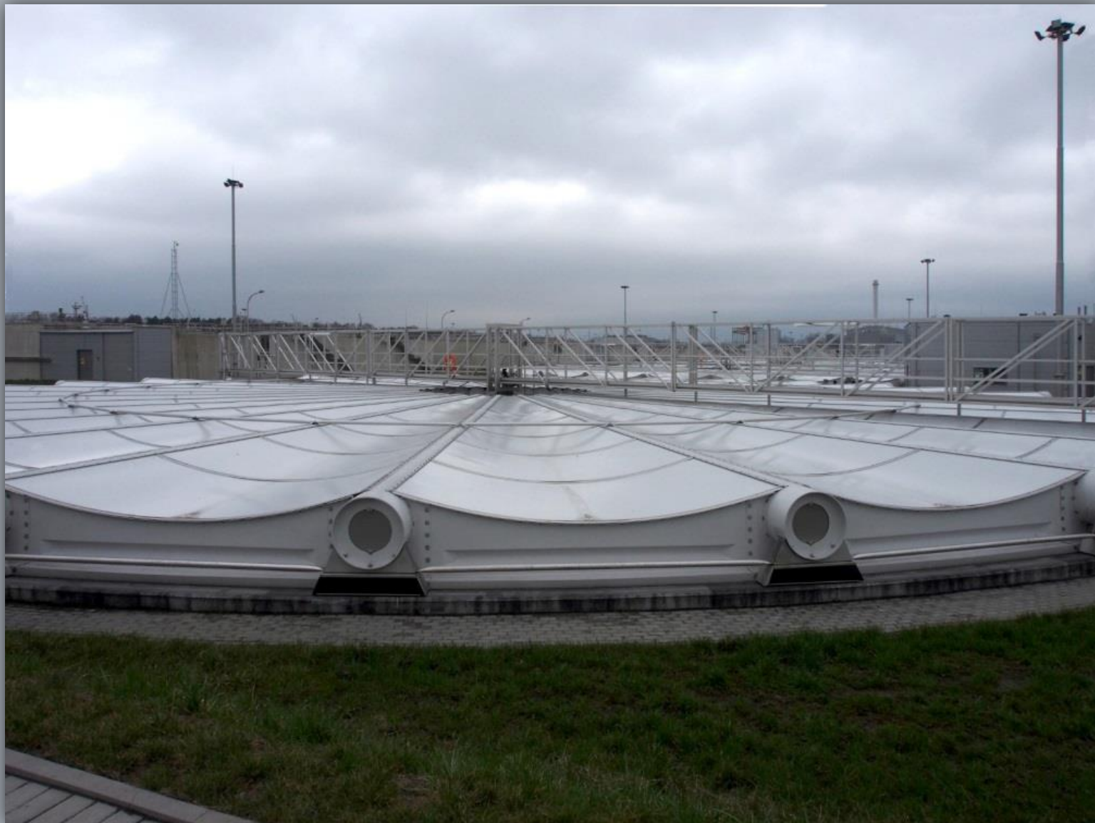
Osadnik wstępny o średnicy 50 m i głębokości 3,3 m
