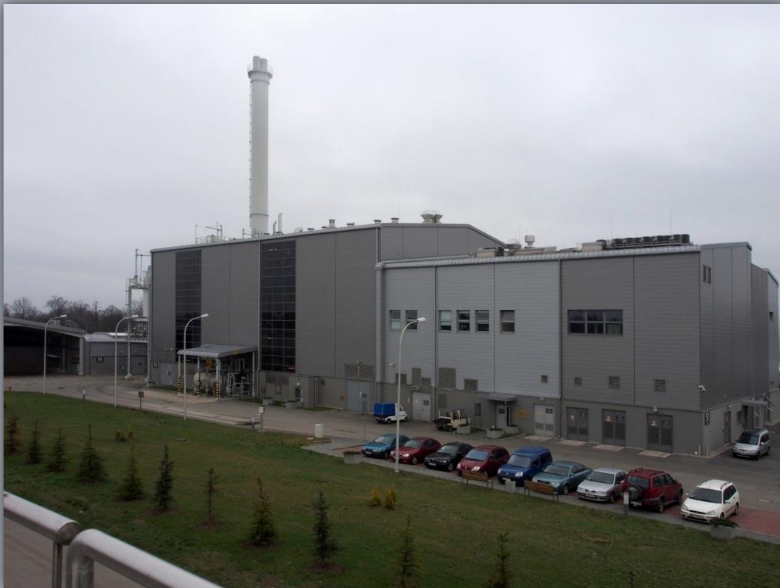
Stacja Termicznej Utylizacji Osadów Ściekowych
