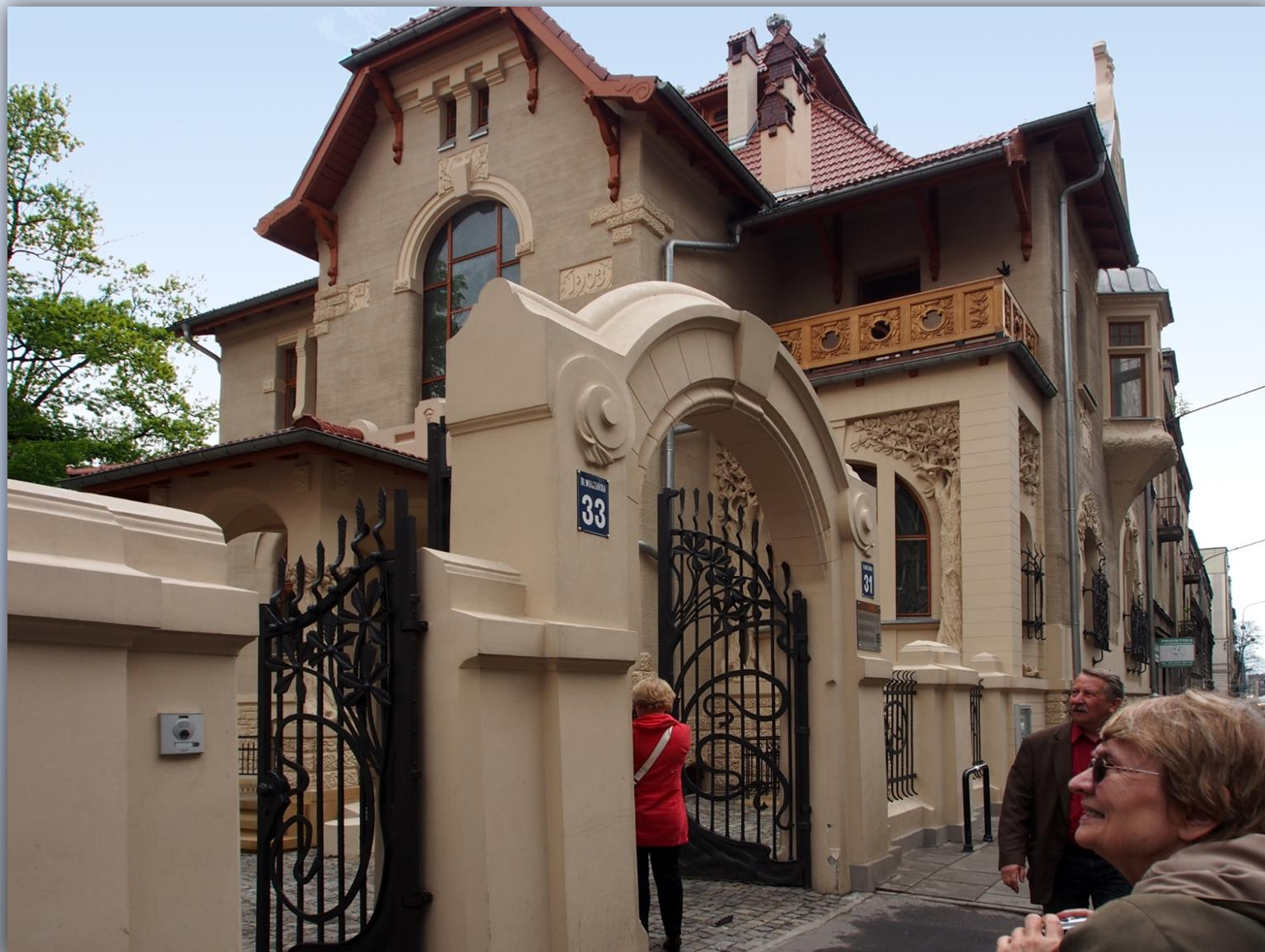
Elewacji willi Kindermanna bogato zdobiona secesyjnym elementami
