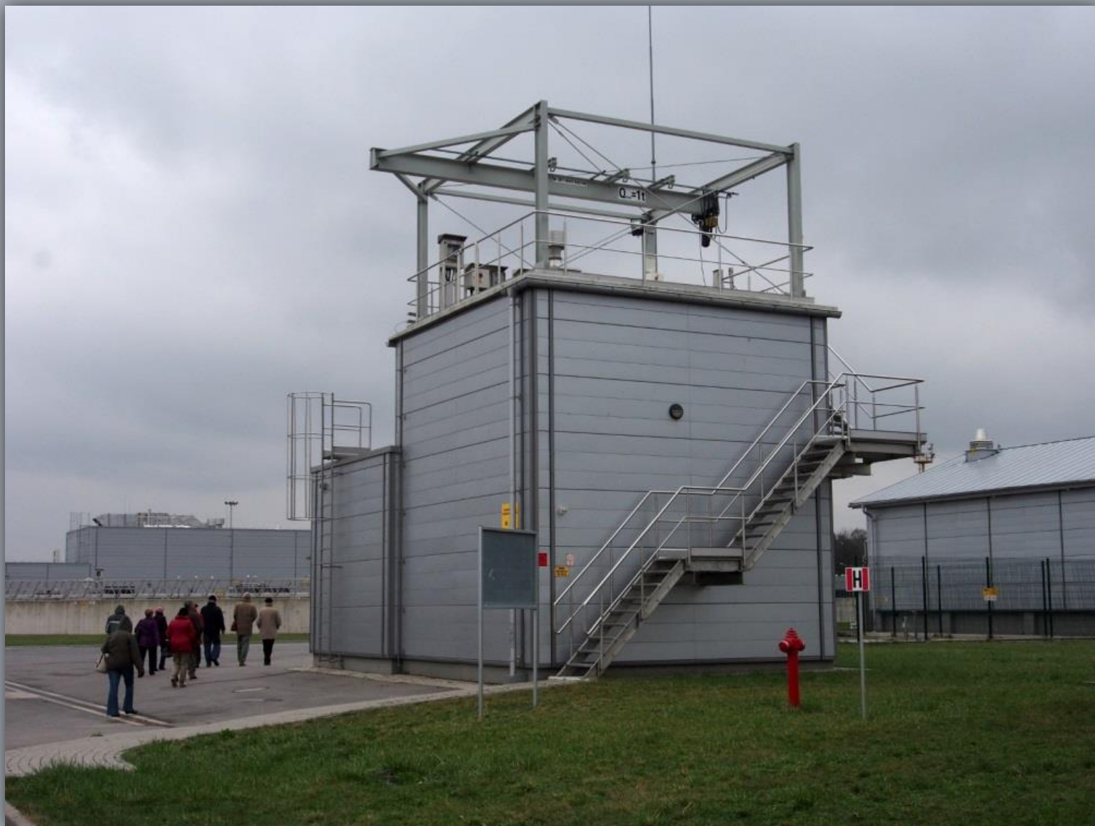
Budynek pompowni opróżniania zbiorników
