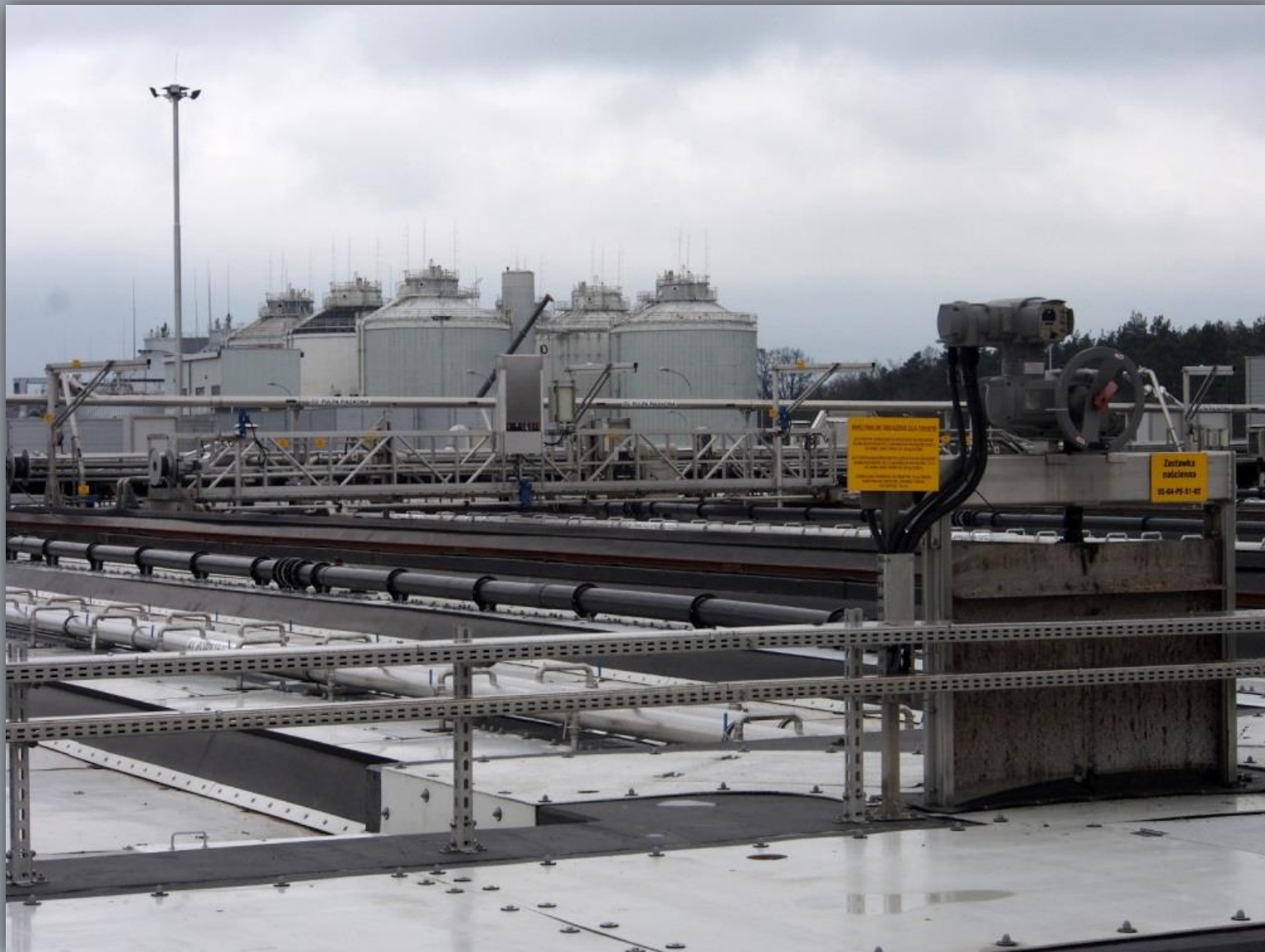
Piaskowniki z odtłuszczaczami do oddzielania osadów mineralnych
