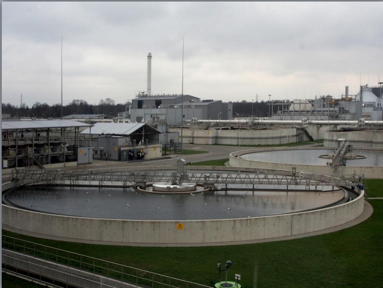
Osadniki wtórne i reaktory biologiczne
