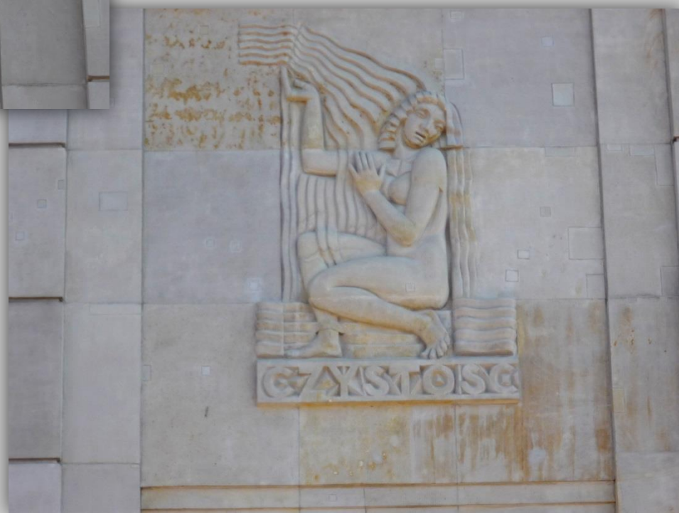
Elementy dekoracyjne na elewacji budynku Filtrów Pospiesznych
