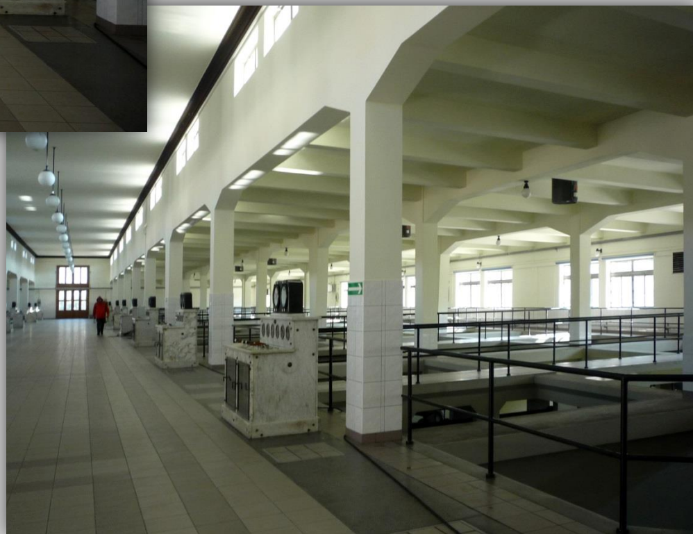
Hala wstępnego oczyszczania wody w Filtrach Pospiesznych
