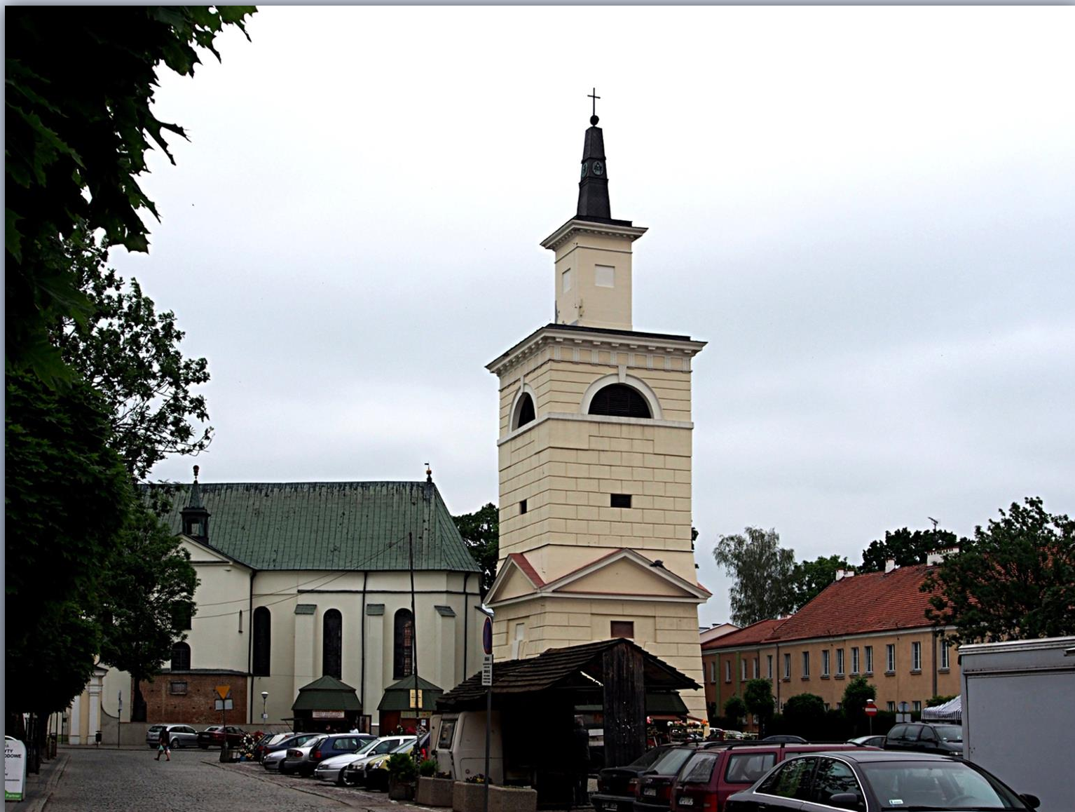
Dzwonnica klasycystyczna, czterokondygnacyjna, wzniesiona w 1507 r.
