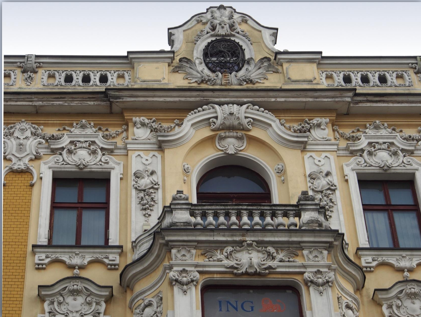
Fragment elewacji kamienicy Steigera z ornamentami neobarokowymi
