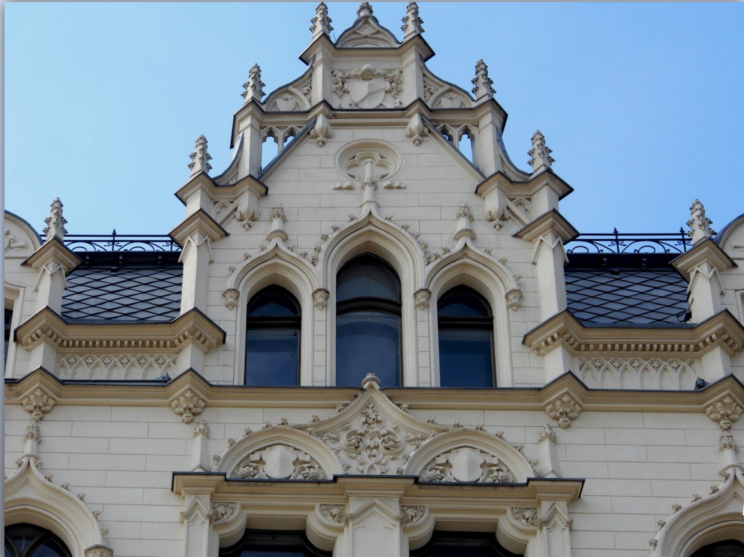
Fragment mansardowego dachu kamienicy Goldbluma, z fryzmem arkadowym pod dachem
