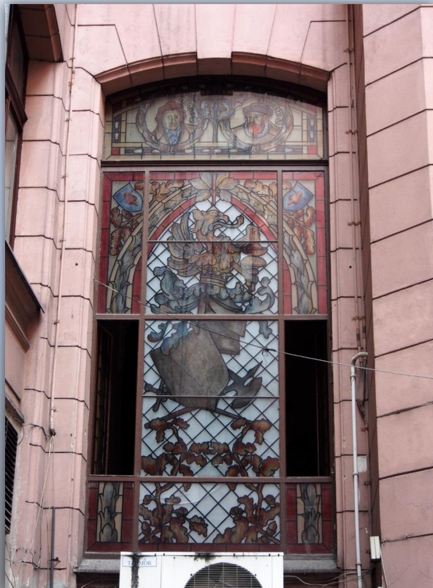
okno na klatce schodowej od strony podwórza
