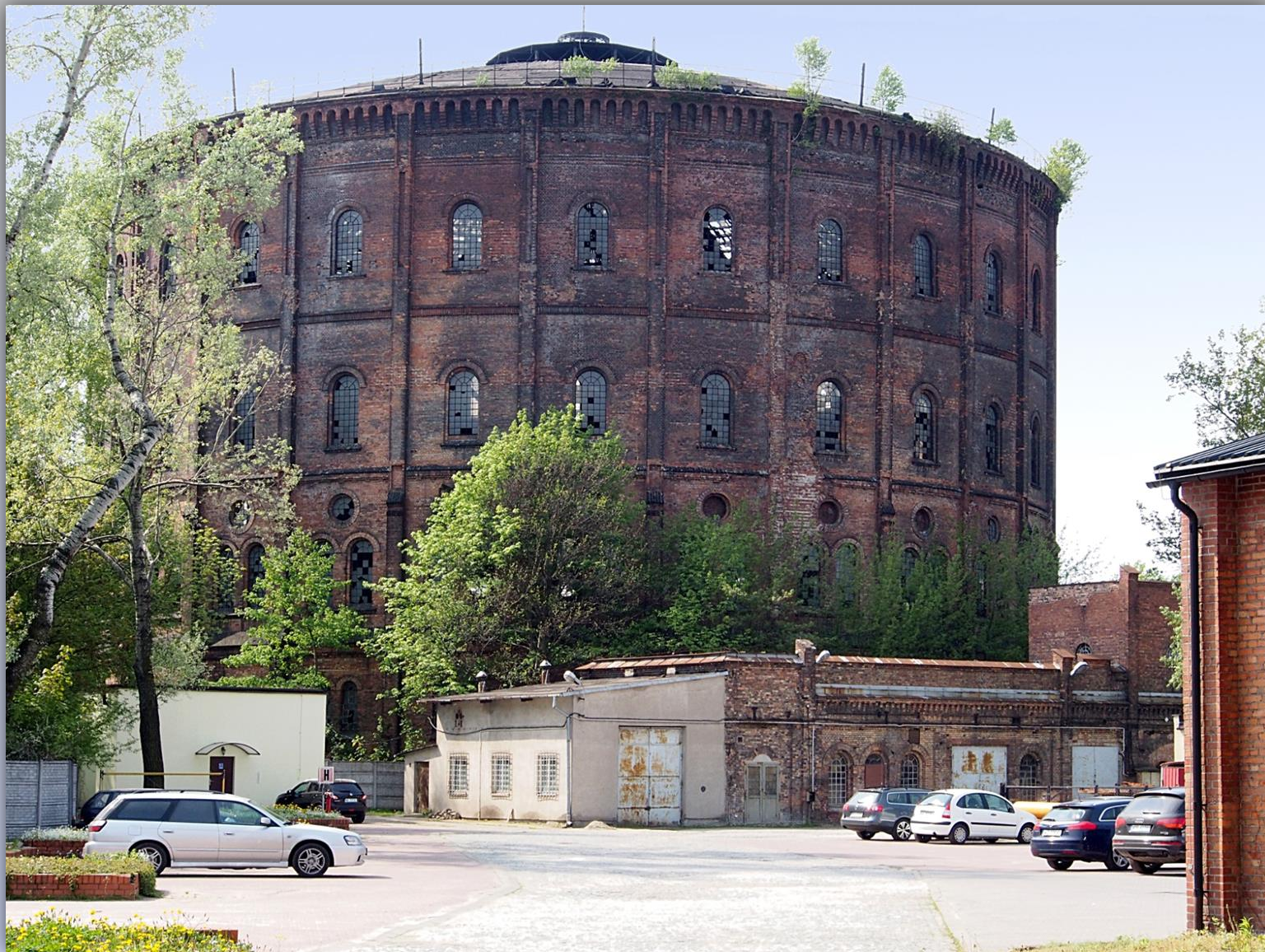
Zaniedbany budynek zbiornika gazu na terenie dawnej Gazowni na Woli
