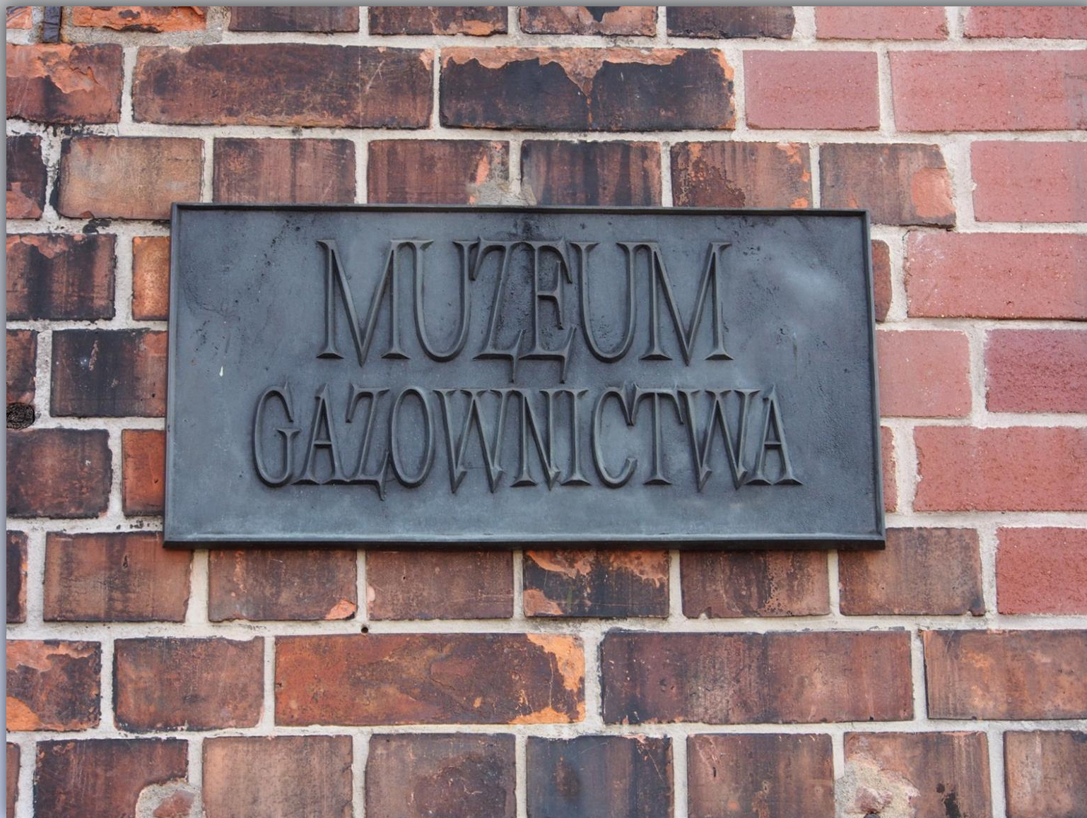
Muzeum mieści się w dawnym budynku aparatowni i tłoczni gazu w Gazowni na Woli
