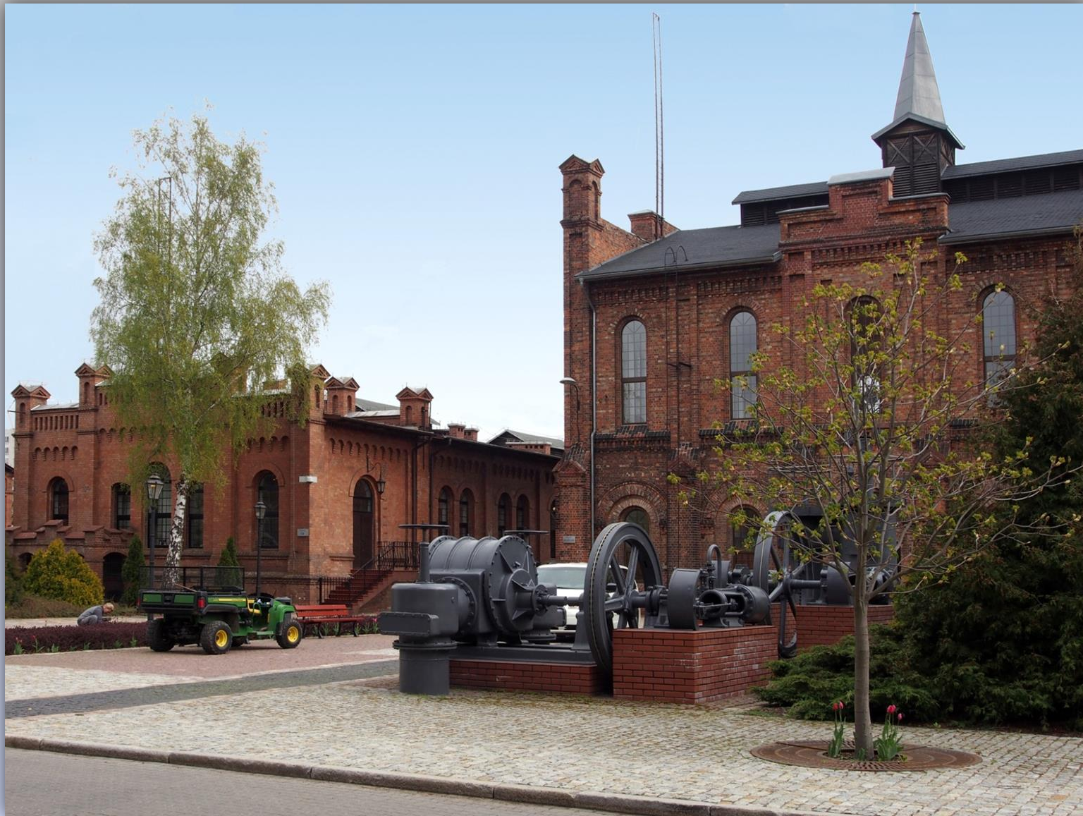
Dawne urządzenia techniczne do przesyłania gazu
