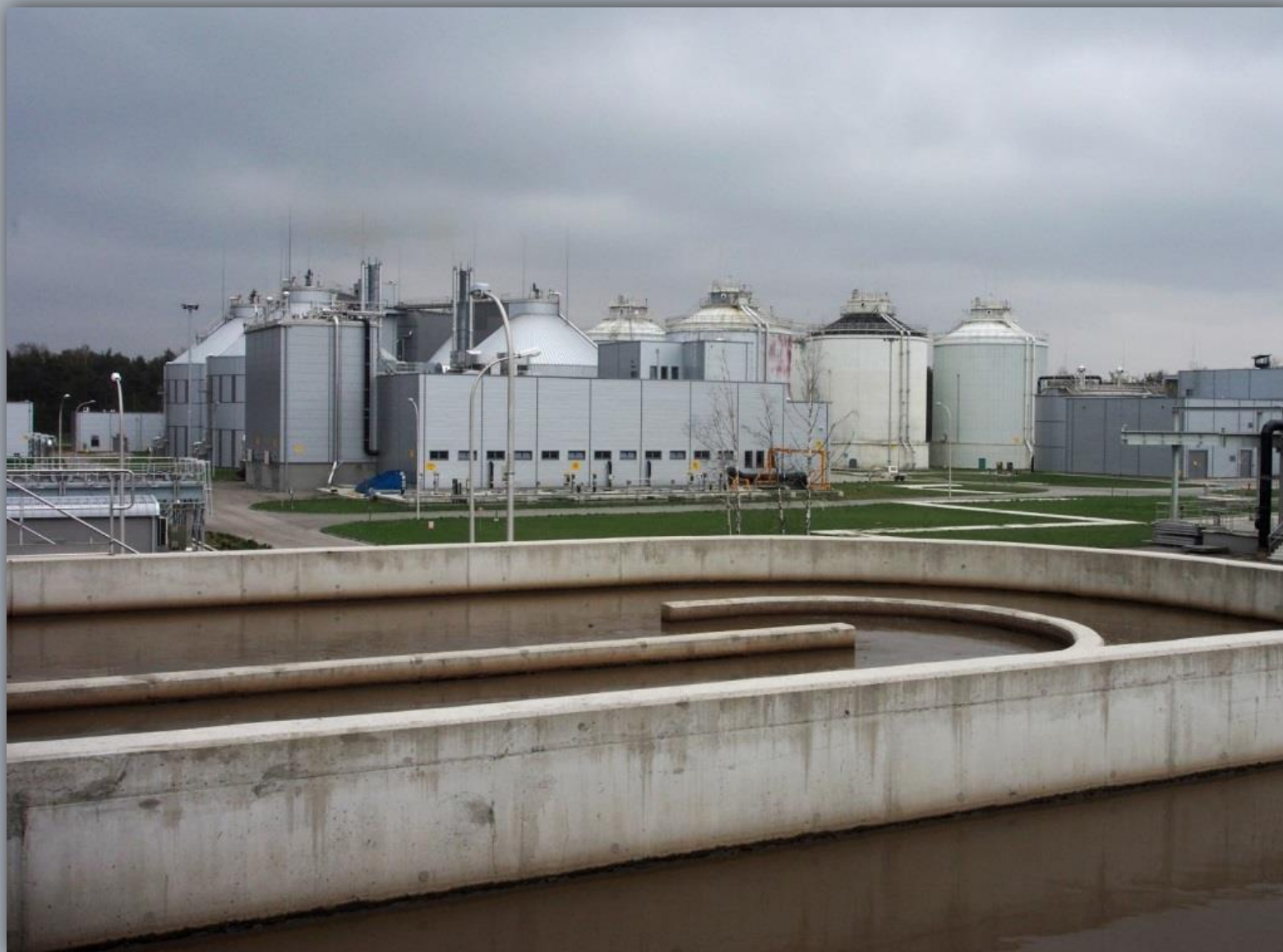
Komory stabilizacji osadu
