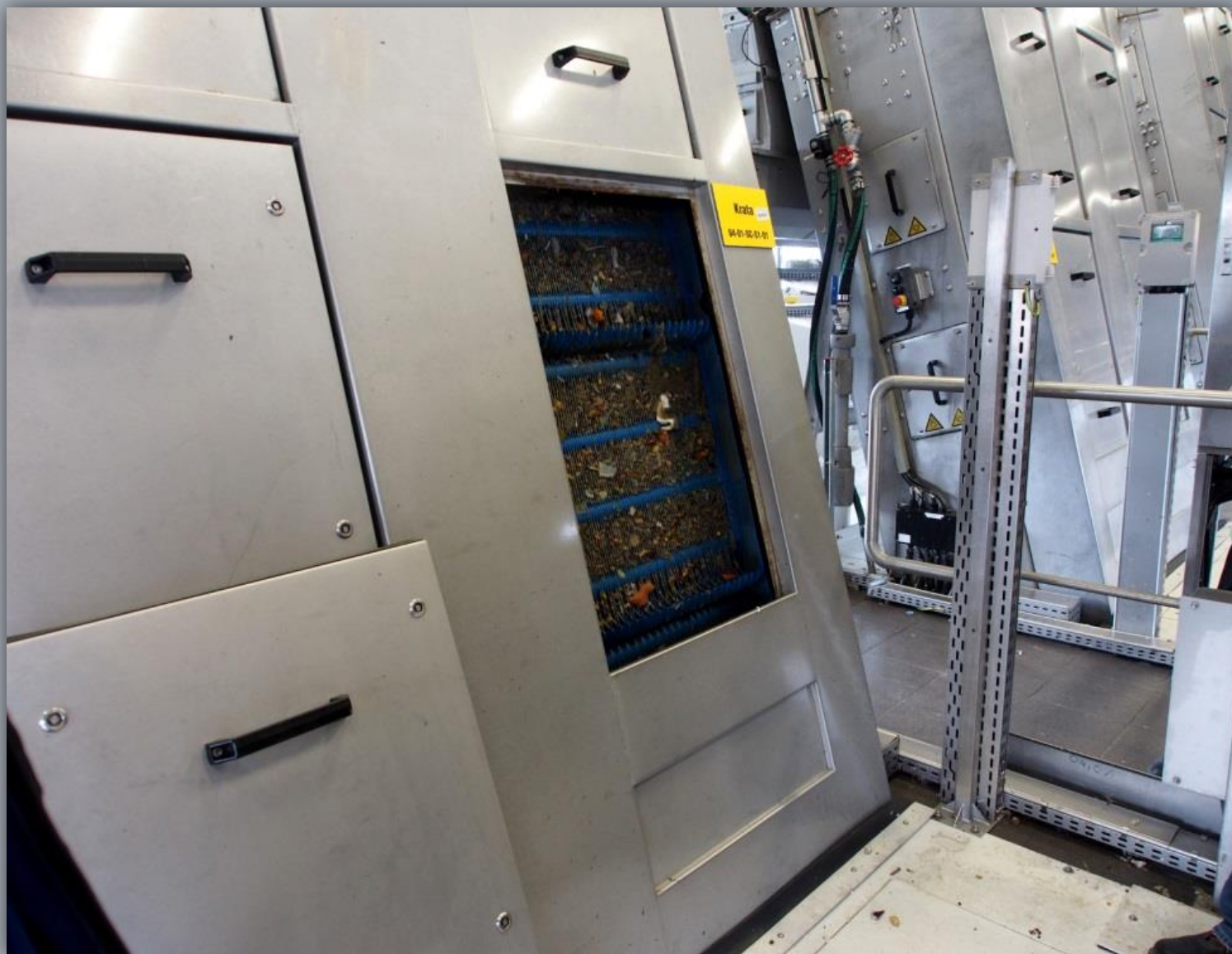
Kraty hakowo-taśmowe do zatrzymywania stałych zanieczyszczeń
