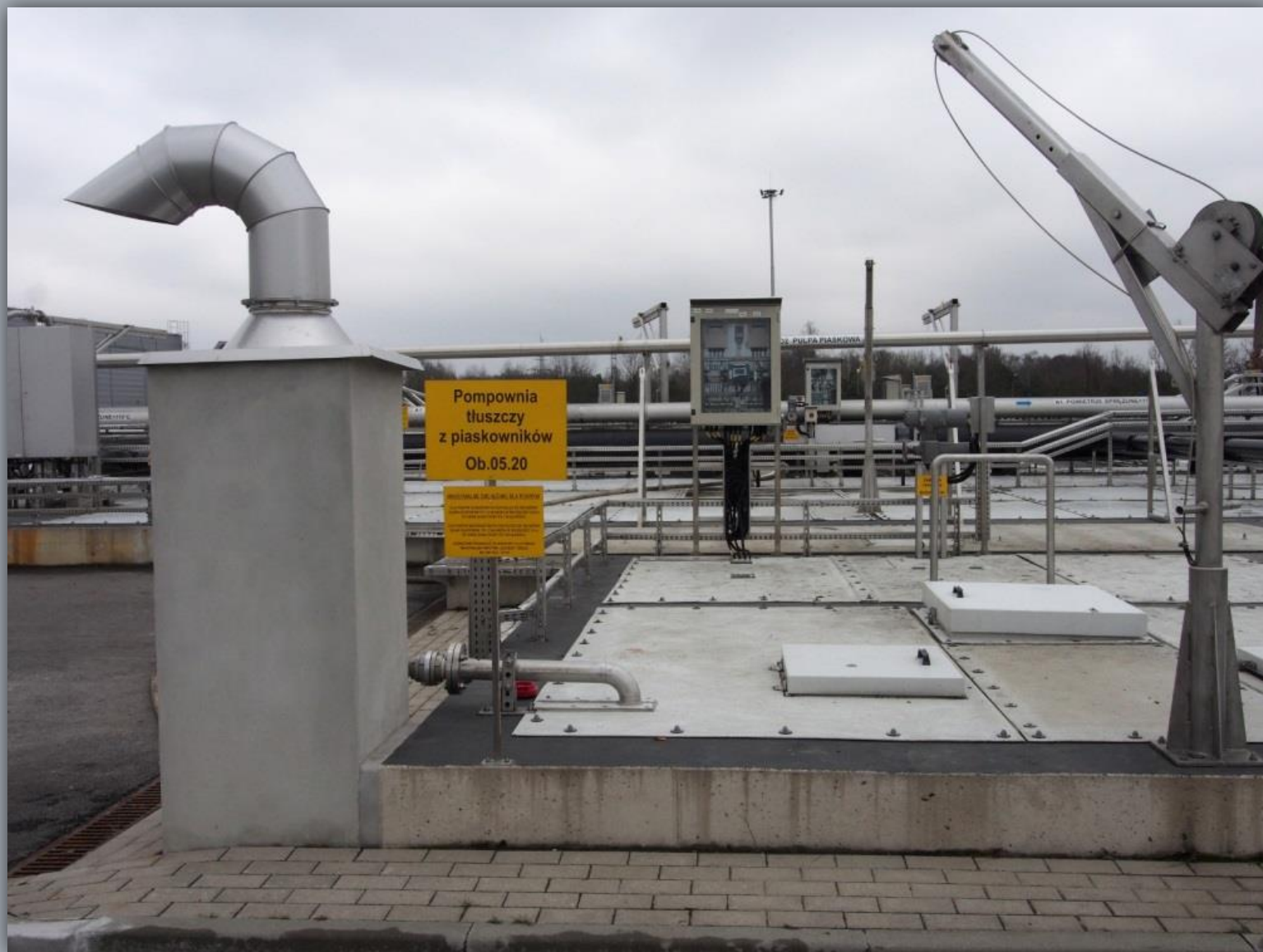
Pompownia tłuszczu z piaskowników
