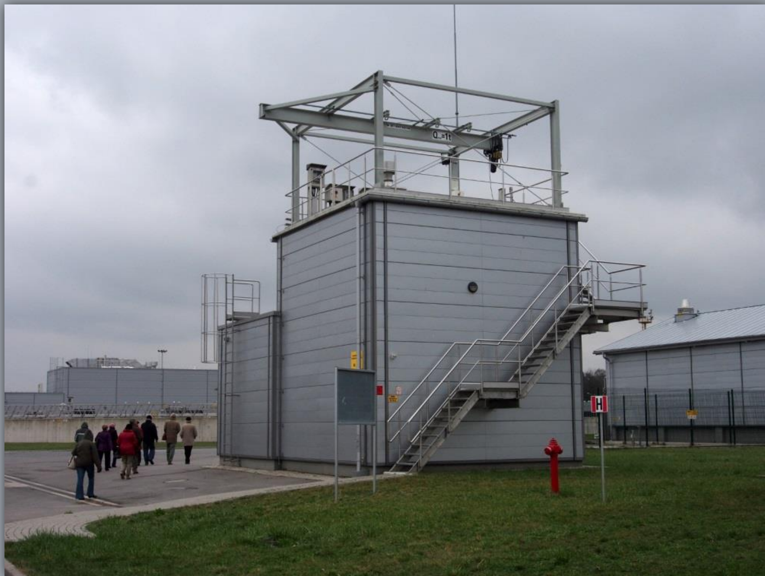
Budynek pompowni opróżniania zbiorników
