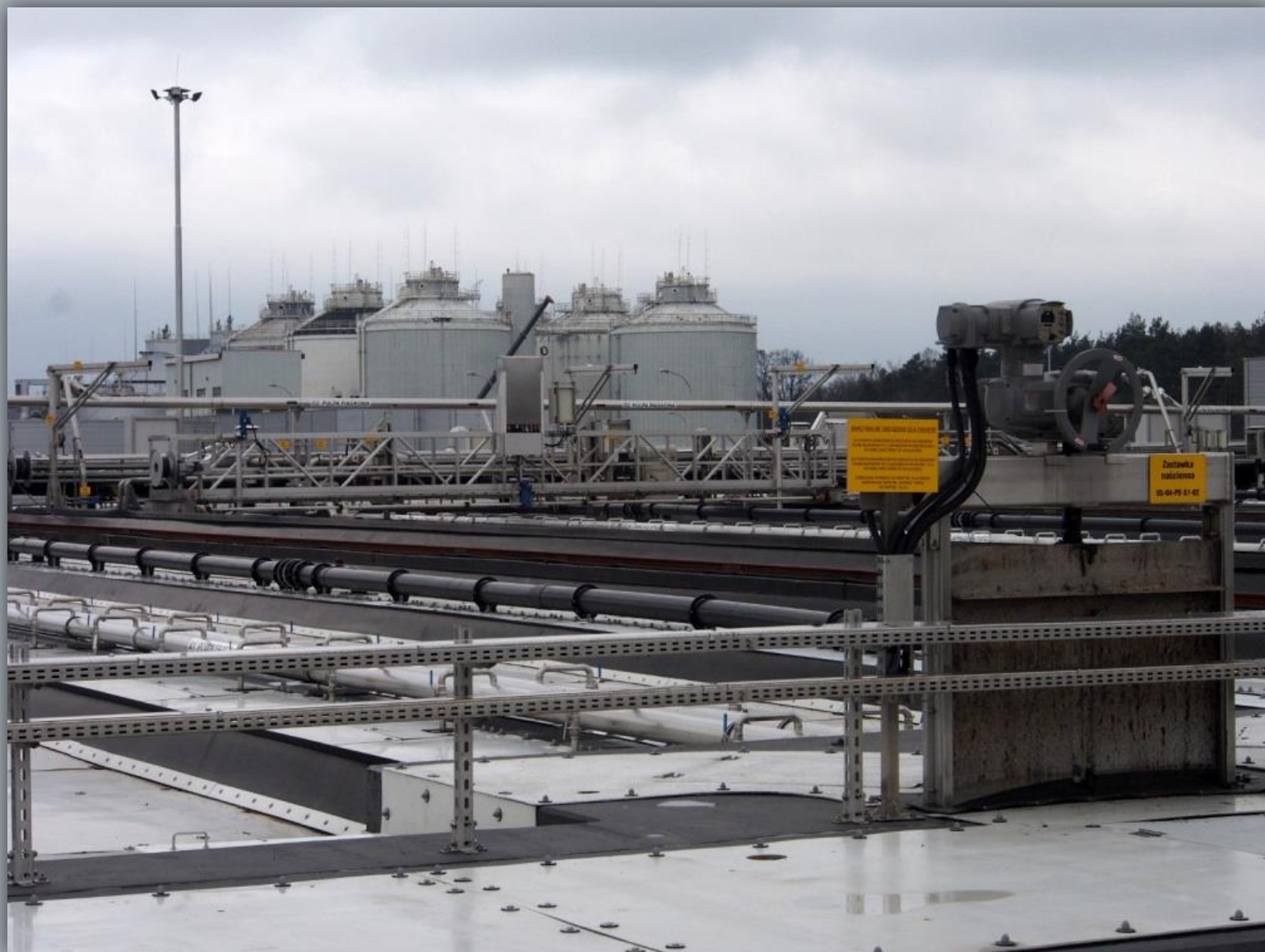
Piaskowniki z odtłuszczaczami do oddzielania osadów mineralnych
