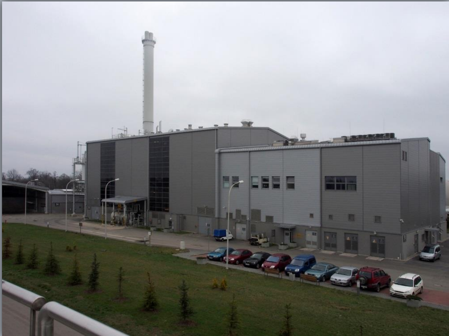
Stacja Termicznej Utylizacji Osadów Ściekowych
