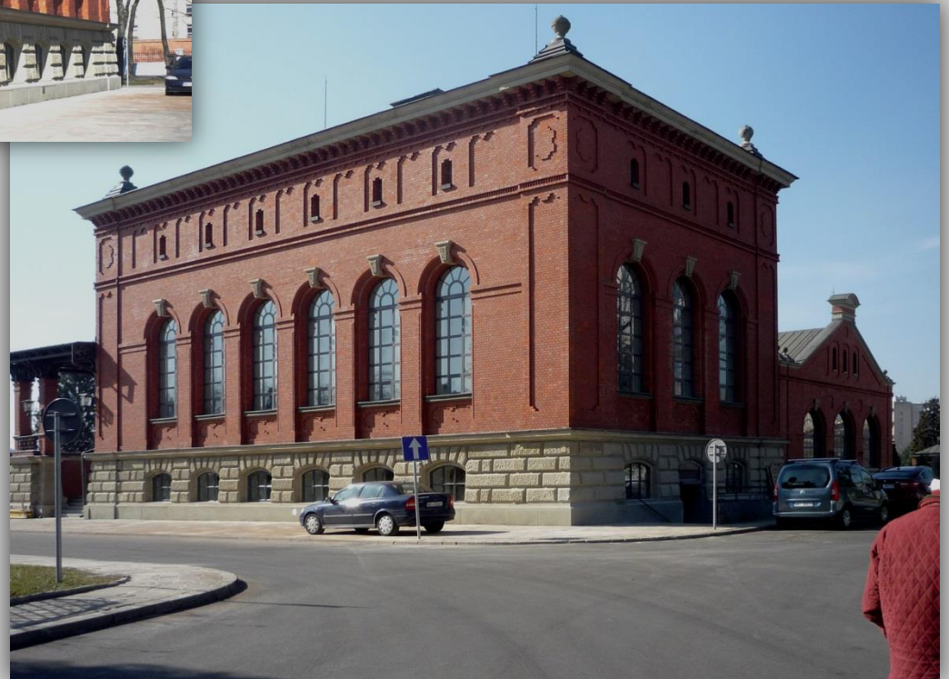
Budynek techniczny nr 2 zbudowany w latach 1899-1900 (obecnie Muzeum)
