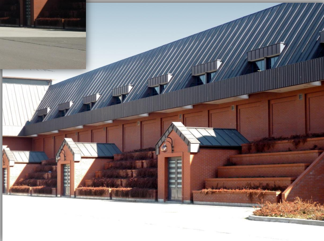
Budynek stacji ozonowania wody
