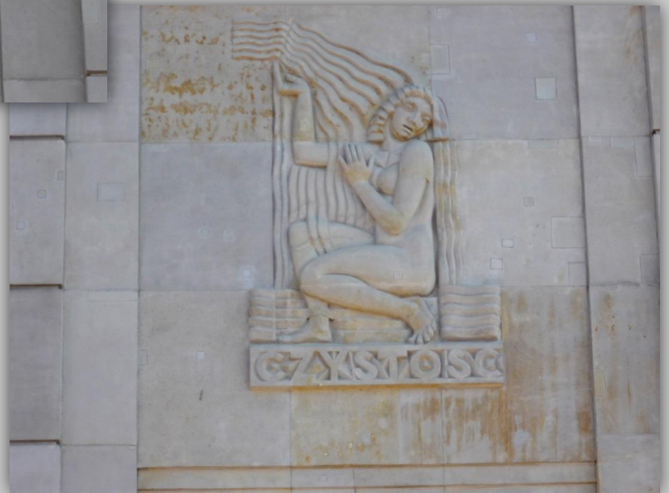
Elementy dekoracyjne na elewacji budynku Filtrów Pospiesznych
